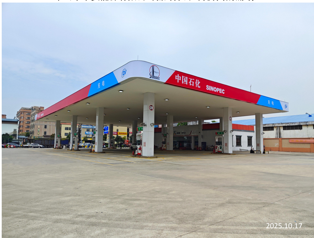
中山市中安能源有限公司富辉分公司现场勘察影像：
