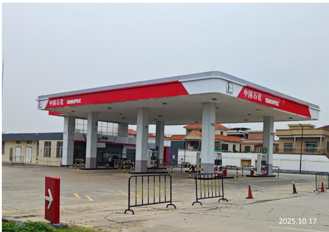
中山市中安能源有限公司富兴分公司现场勘察影像：
