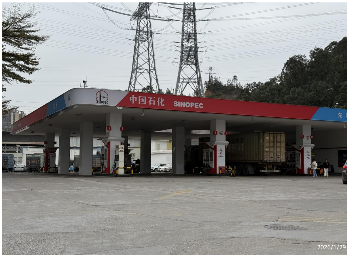
中国石化销售股份有限公司广东东莞樟木头樟洋加油二站现场勘察影像：
