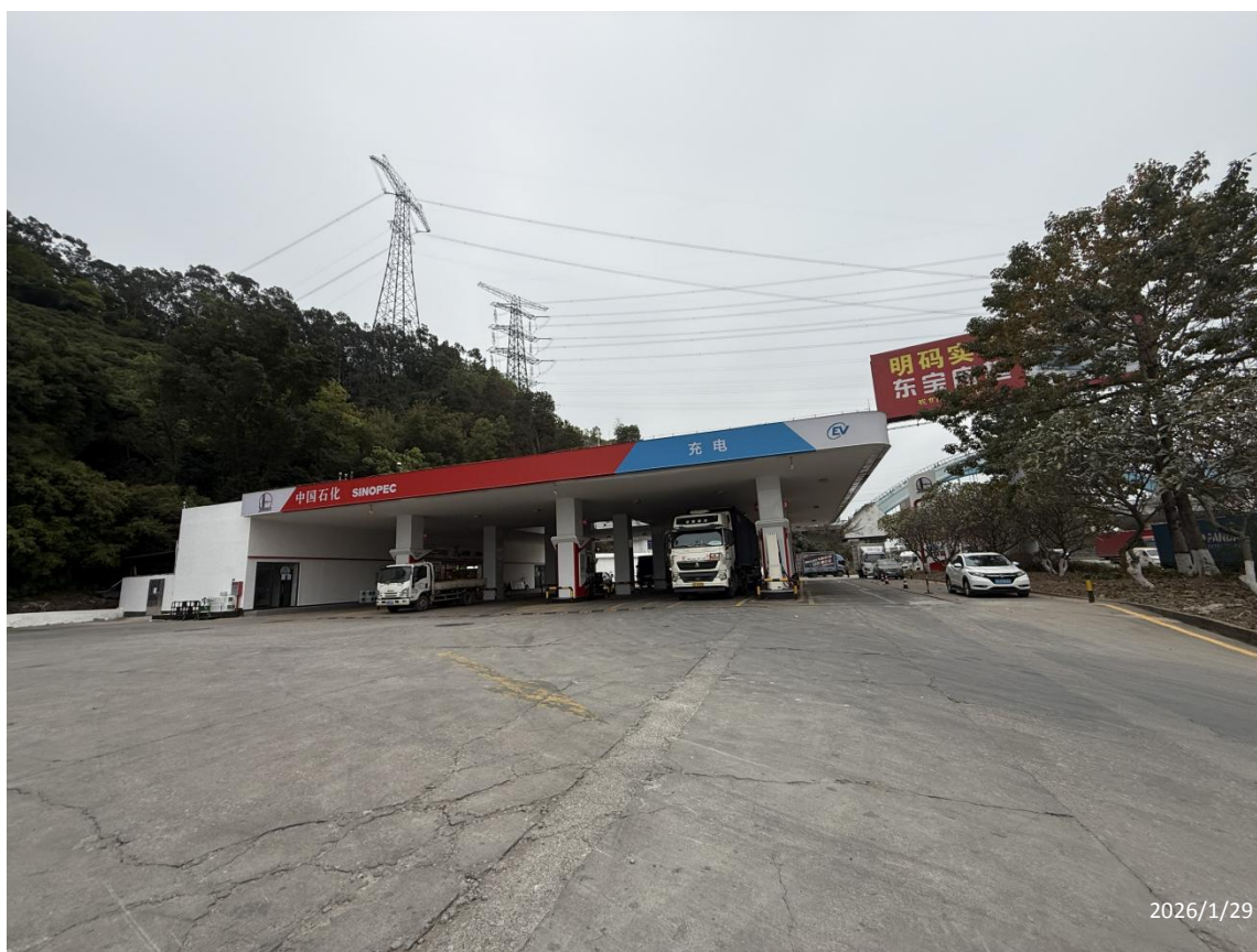
中国石化销售股份有限公司广东东莞樟木头樟洋加油站现场勘察影像：
