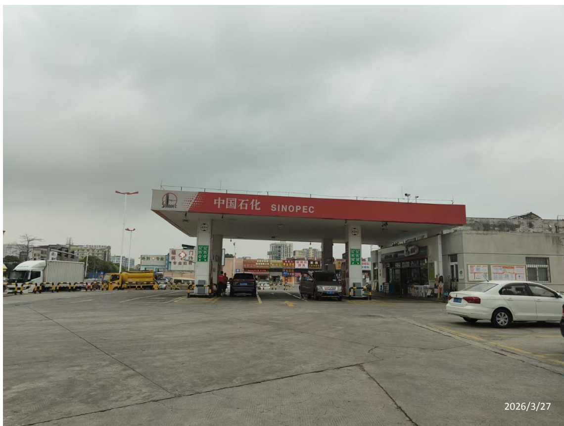
中国石化销售股份有限公司广东东莞石排福隆加油站现场勘察影像：
