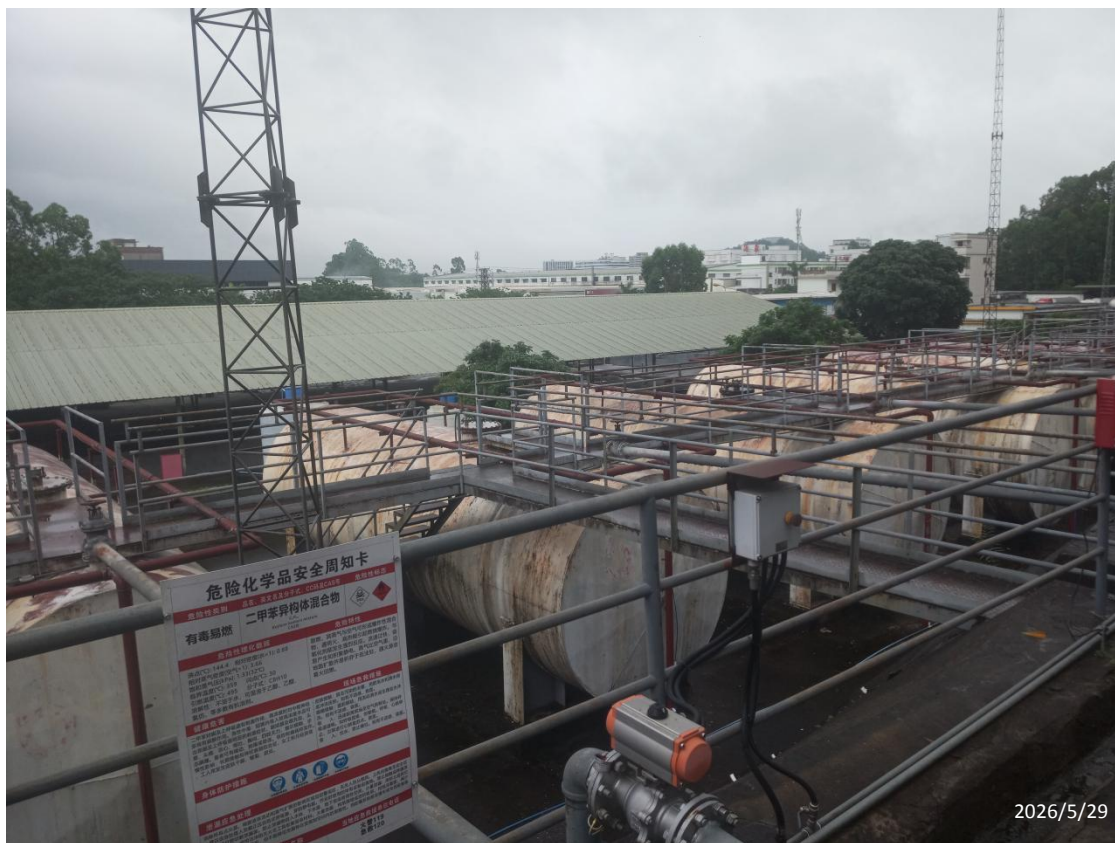
江门市广源洪化工实业有限公司现场勘察影像：
