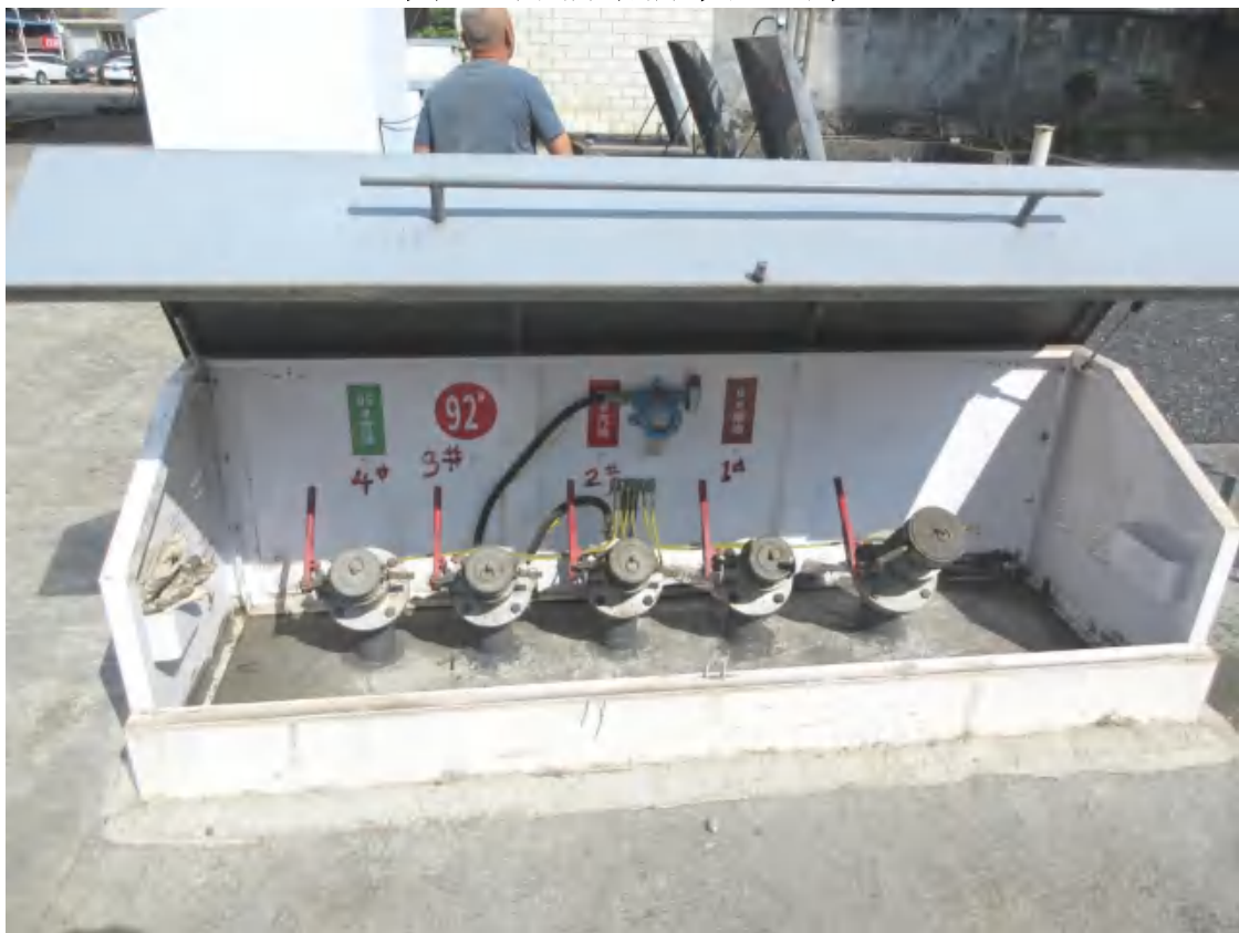
图 5：加油站卸油口照片
