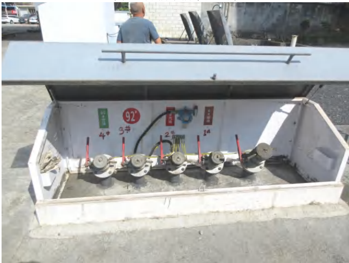
图 5：加油站卸油口照片
