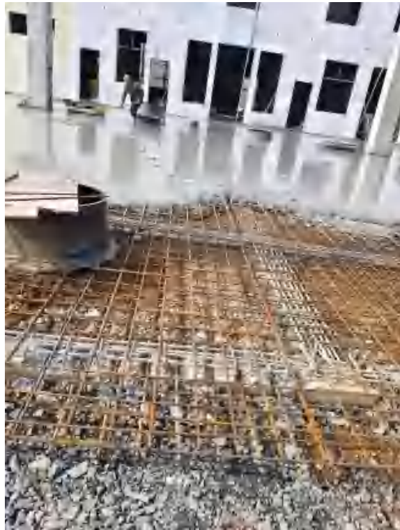
隐蔽工程照片 4
