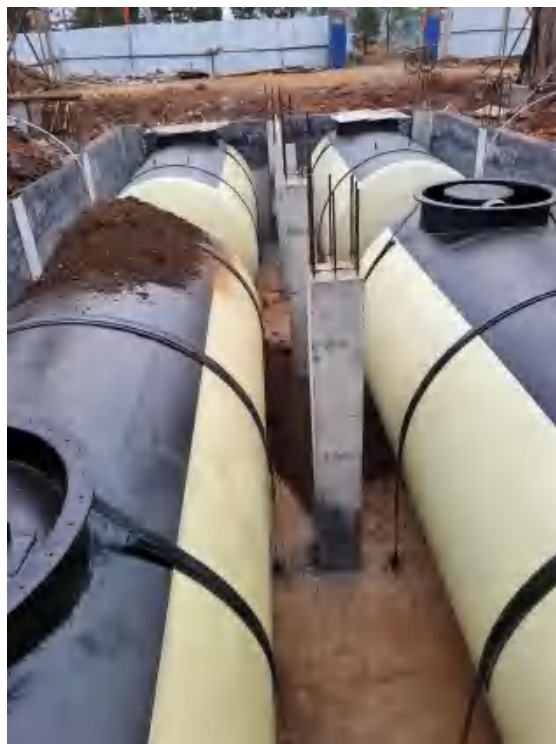
隐蔽工程照片 2
