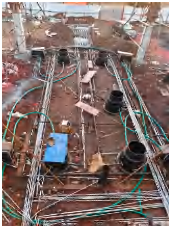
隐蔽工程照片 3
