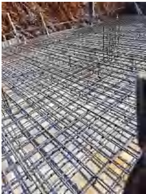
隐蔽工程照片 1
