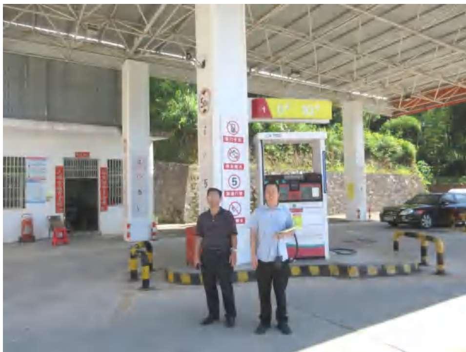
图 6：评价人员现场勘察照片（二）
