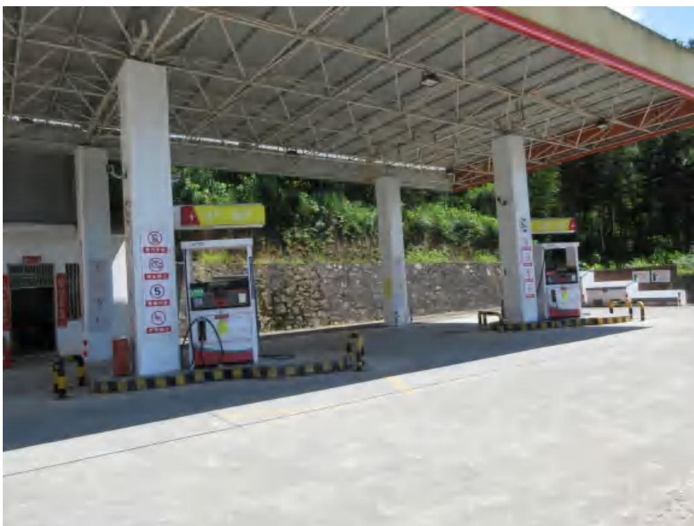
图 2：加油站加油机照片
