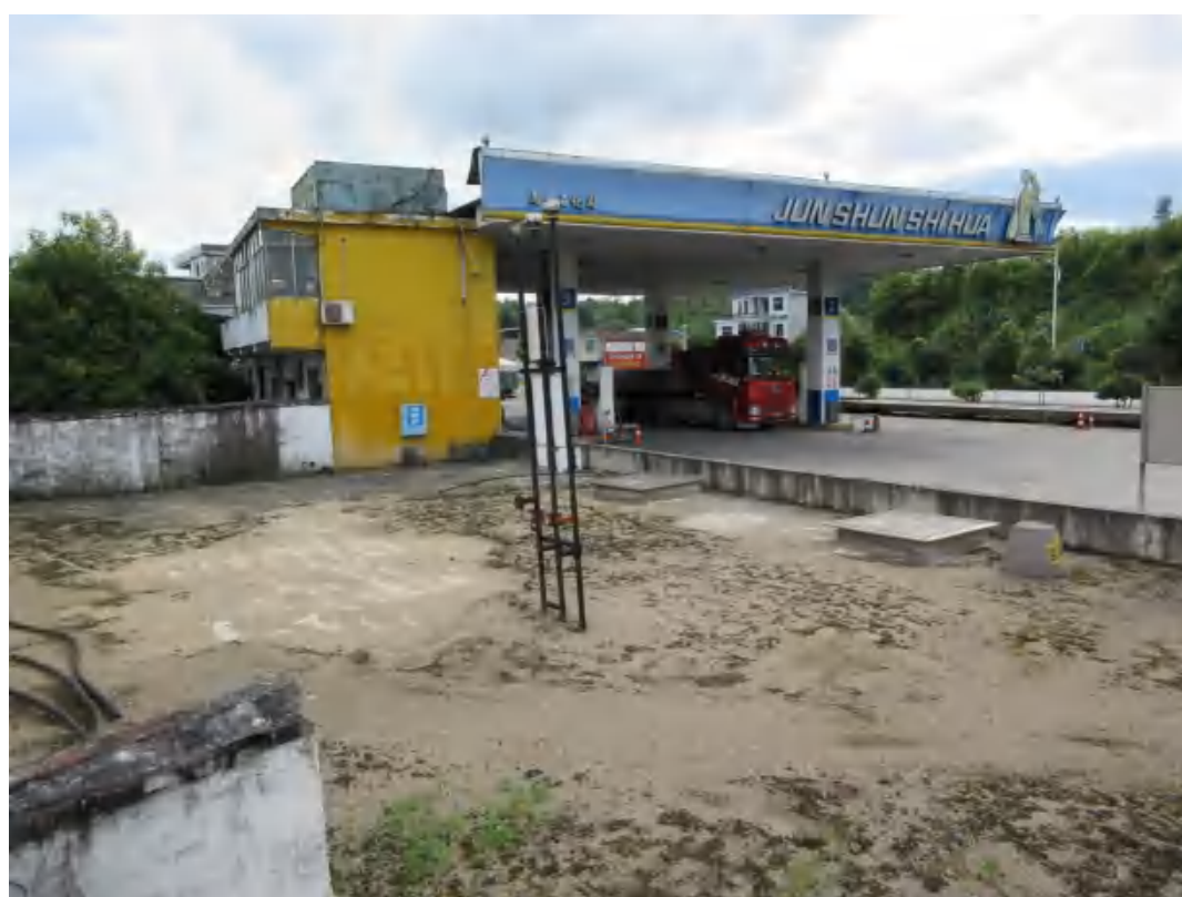
图 4：加油站油罐区照片
