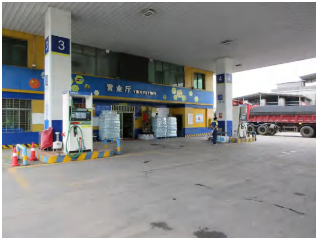
图 3：加油站加油机照片
