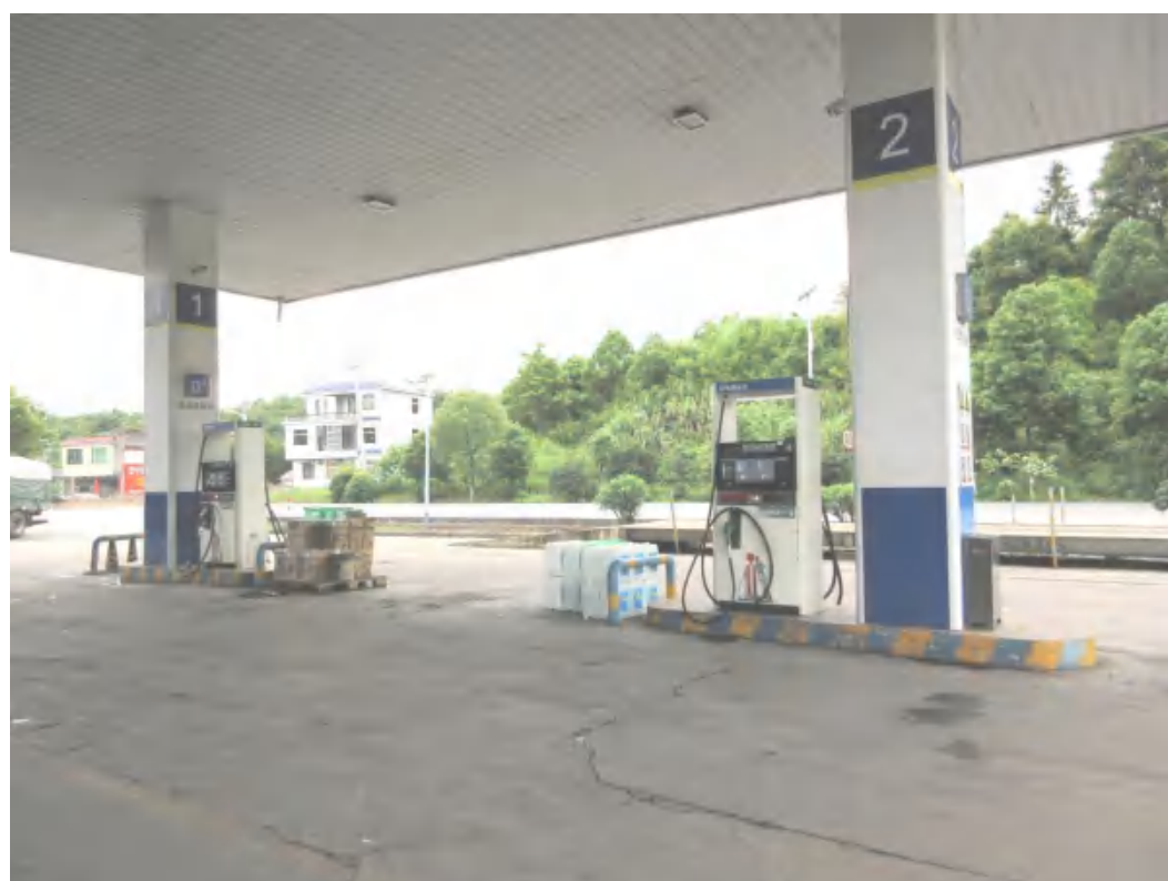
图 2: 加油站加油机照片
