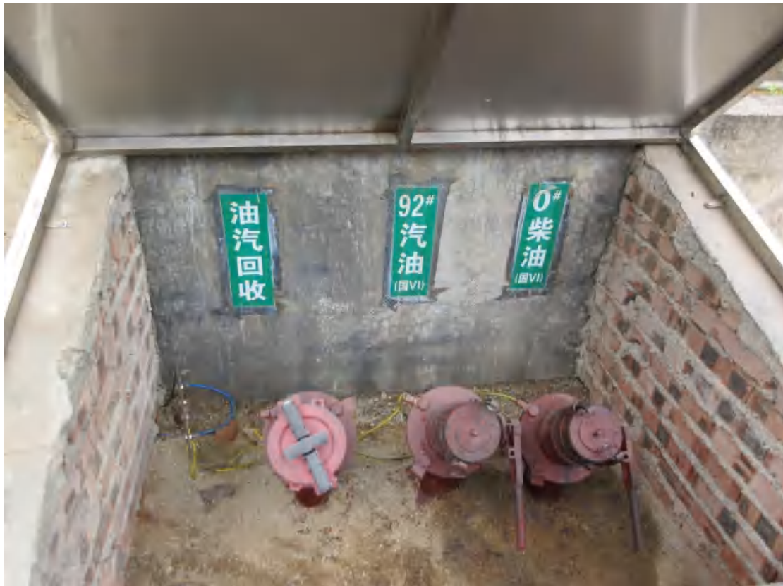
图 4：加油站卸油口照片
