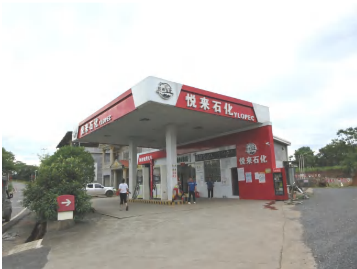
图 1：加油站加油区照片
