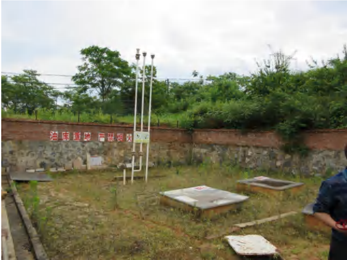
图 3：加油站油罐区照片
